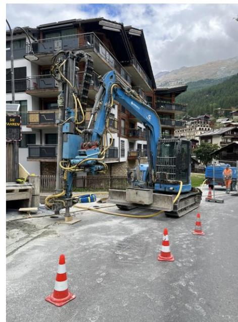
*Bohren von Micropfählen durch die bestehende Widerlagerwand*
