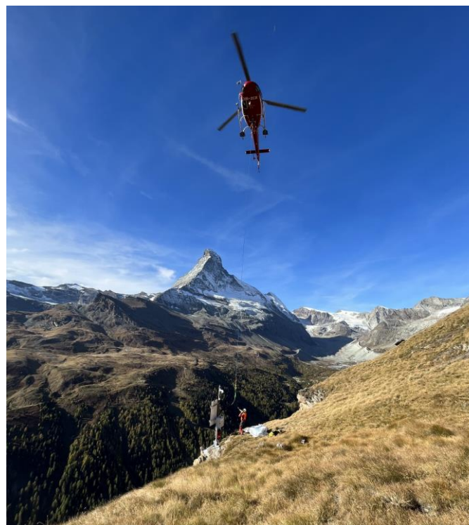
Versetzen einer Überwachungsanlage mit dem Hubschrauber
