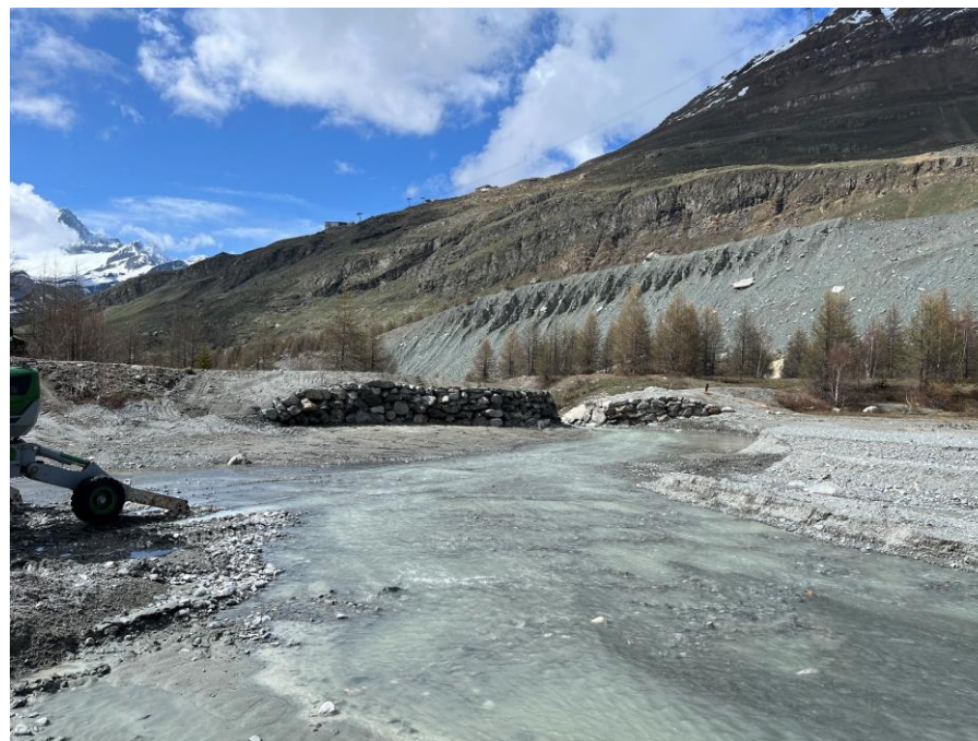
Instandsetzung Damm im Gant
