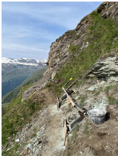
Fundamentplatten für die neuen Verbauungselemente
