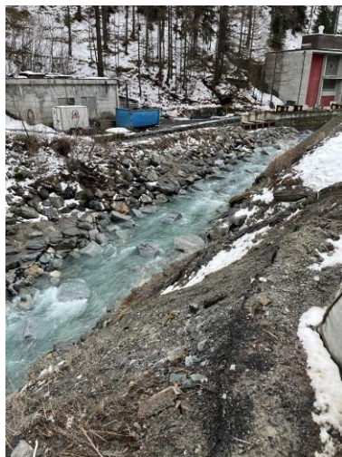
Sohlenstabilisierung mit mächtigen Steinen
