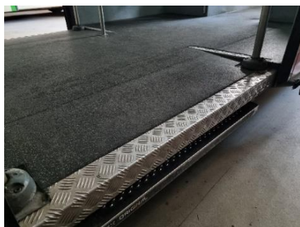
Einbau eines rutschfesten Bodens
