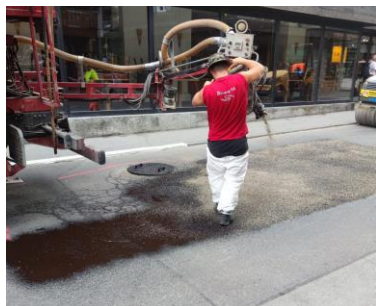
Blow-Patcher in der Bahnhofstrasse
