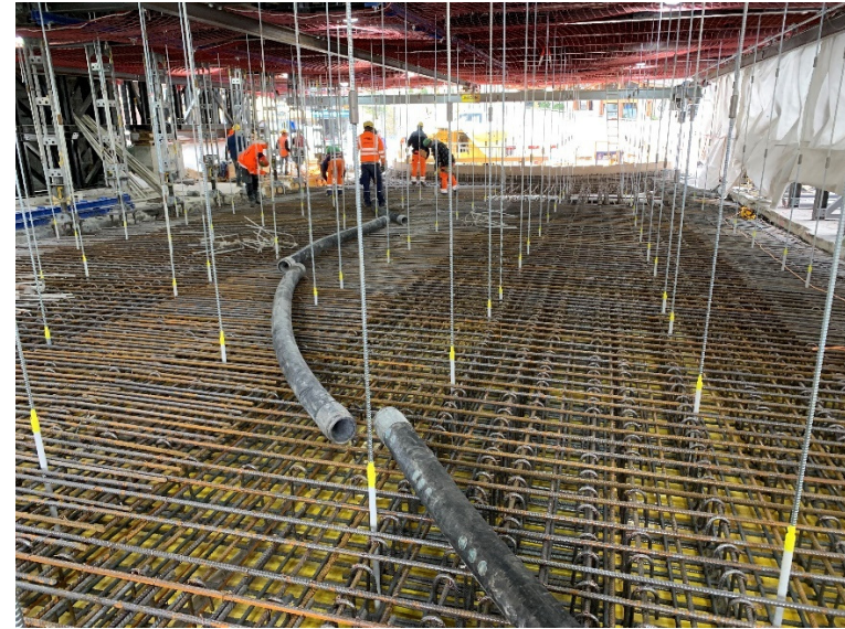
Foto vom 29. April 2021 (letzte Vorbereitungsarbeiten vor dem Betonieren der Brückenplatte)
