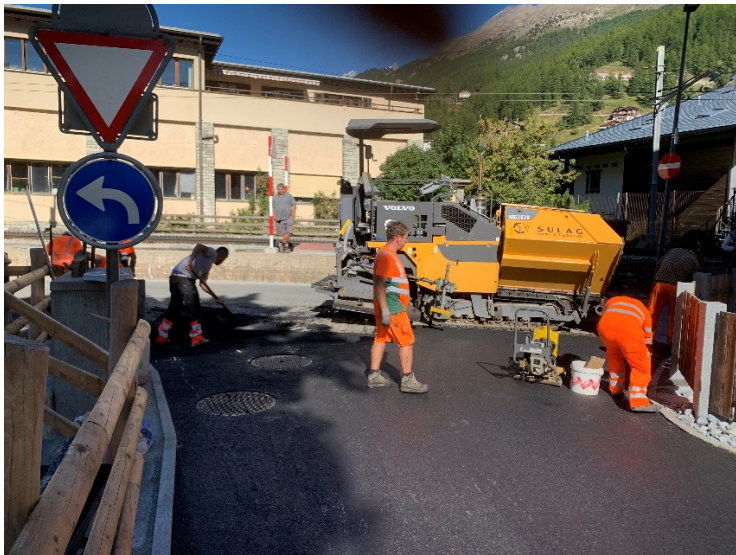
Am 24. September 2021 werden Belagsarbeiten in der oberen Mattenstrasse ausgeführt
