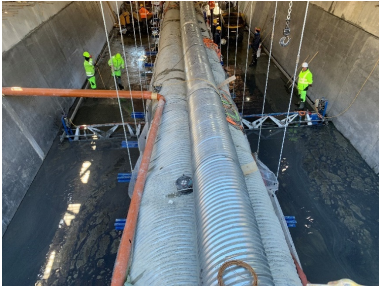
Foto vom 8. April 2021 (das Betonieren der Bodenplatte mit aufgehängter Wasserhaltung)
