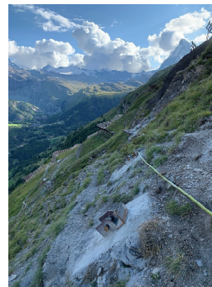
Foto vom 25. August 2021 (vorbereitete Ankerplatten für die Montage der Stahlstützwerke)
