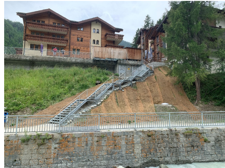
Foto vom 12. Juli 2021 (Umgebungsarbeiten)
