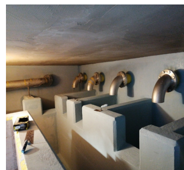
Sanierung Quellen und Brunnenstube Lööbre 2019
