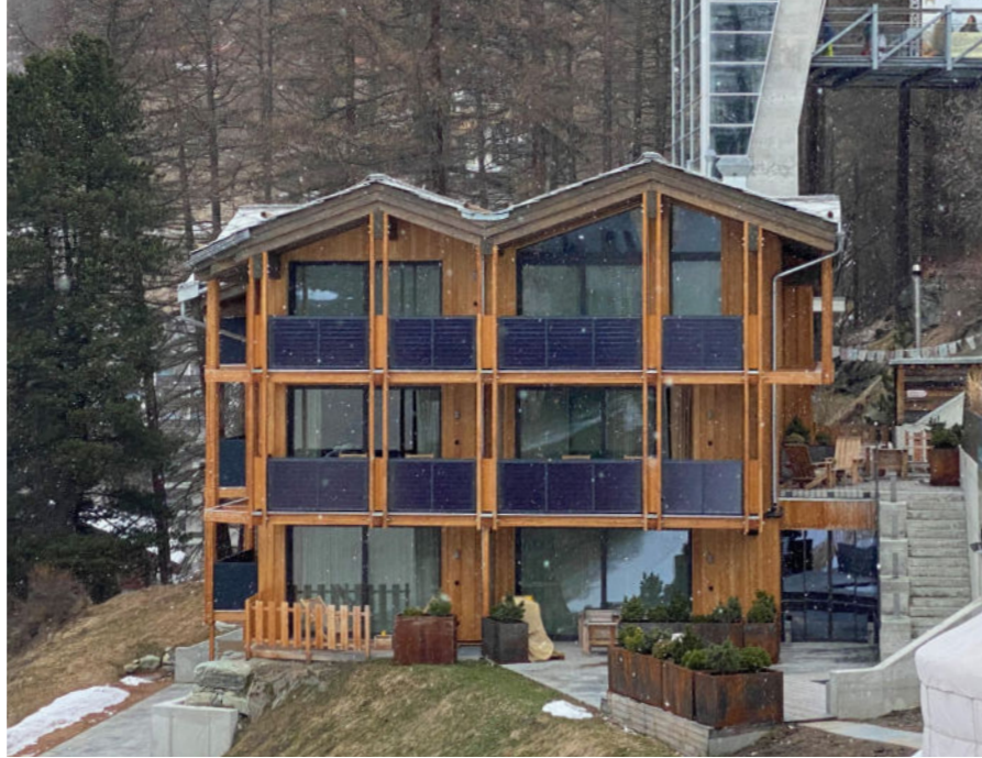
Solaranlagen an der Fassade
