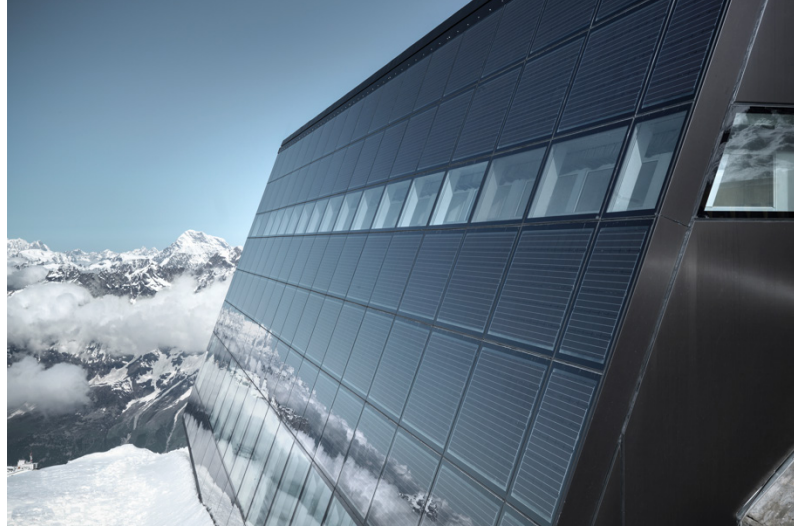
Solaranlage bei Zermatt Bergbahnen
