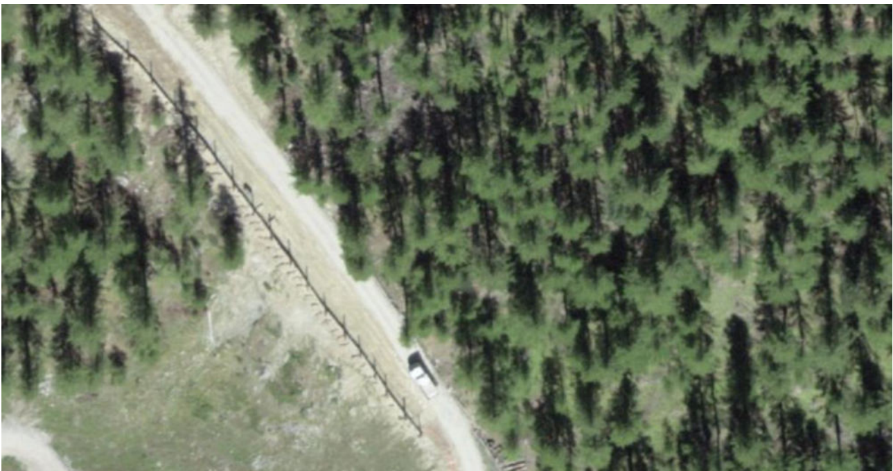
Abbildung 16: Ortofoto best. Stützbauwerk vor dem «Schweigmattenhang»
