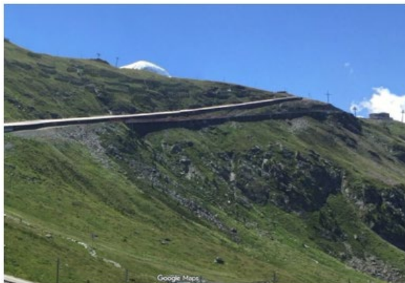
Abbildung 7: Links: Foto Blick Richtung Süd auf Riffelbord-Galerie
